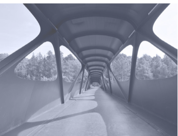
Boulevard Kennedy 1 4170 Esch-sur-Alzette Luxembourg voetgangersbrug, Ney & Partners
